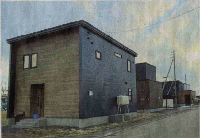
真新しい住宅が立ち並ぶ南幌ニュータウンみどり野4区
